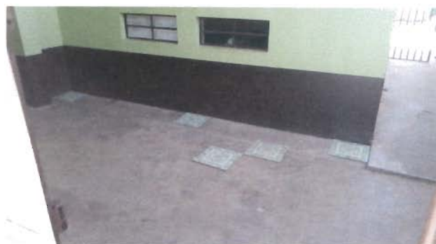
Foto 8: Sustitución de piso cerámico
