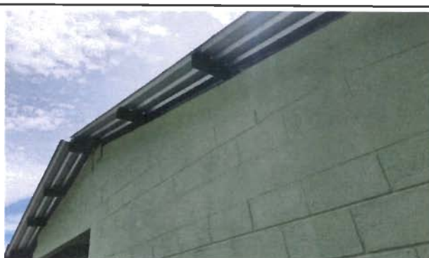
Foto 10: Protección con duela de PVC en paredes más aplicación de espuma expansiva
