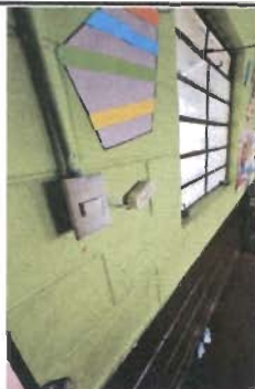
Foto 9: Sustitución de tomacorrientes dobles
