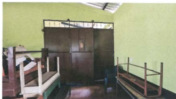
Foto 2: Sustitución de portón de metal
