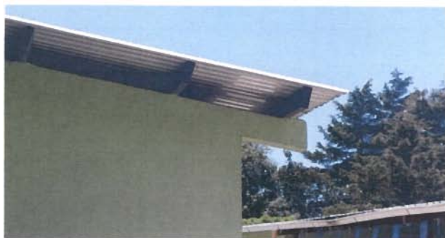
Foto 11: Protección con duela de PVC en paredes más aplicación de espuma expansiva
