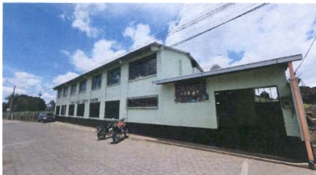
Foto7: Sustitución de vidrios
