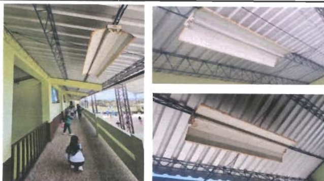
Foto 3: Sustitución de lámparas tipo LED
