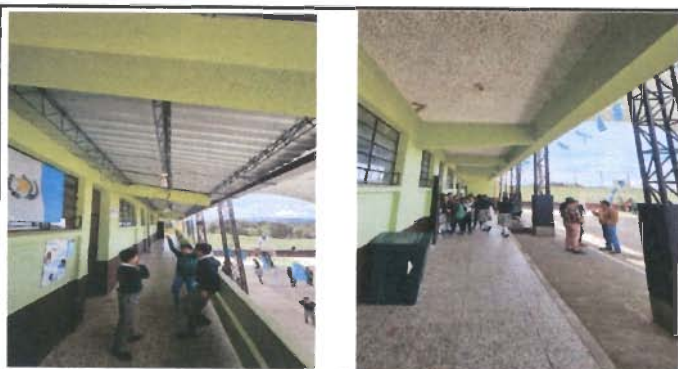
Foto 5: Sustitución de plafoneras
