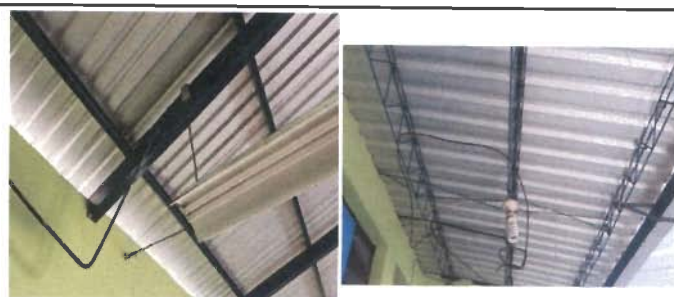
Foto 6: Sustitución de ducto eléctrico + accesorios
